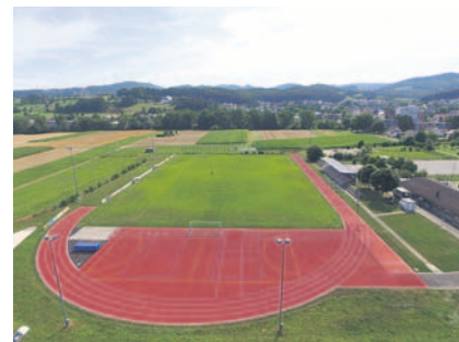
Stückwerk: Die heutige Anlage.
