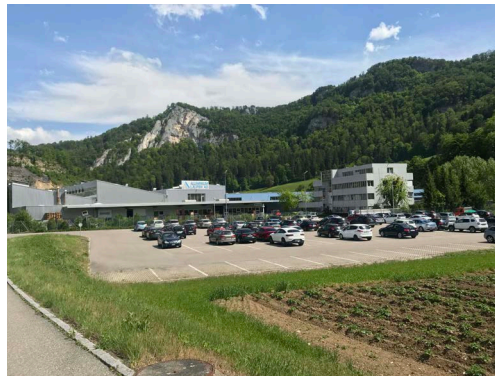
Grosse Parkflächen / Betriebsreserven
