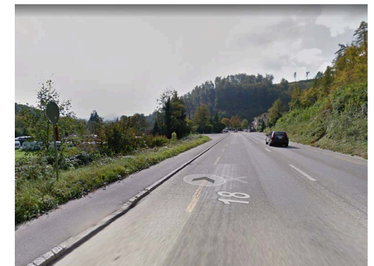
Ortseingang H18 (fehlende Adressierung)
