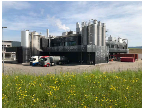
Qualitativ hochwertige Industriebauten
