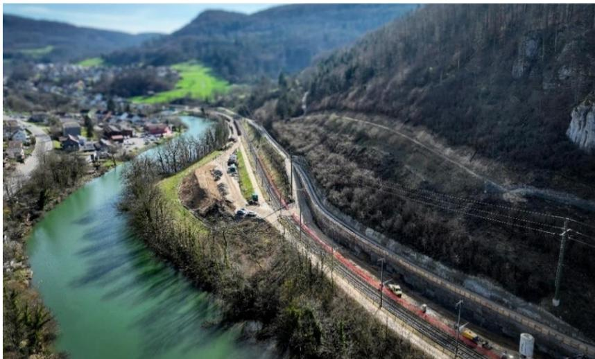
Momentan konzentrieren sich die Bauarbeiten auf den Abschnitt Chessiloch bis Bahnhof Grellingen. Dabei werden die Stützmauer Dägenauer- und Moosweg bis im Sommer (2024) fertig erstellt. Danach folgen die Strassenbauarbeiten beim Dägenauerweg und beim unteren Moosweg.
